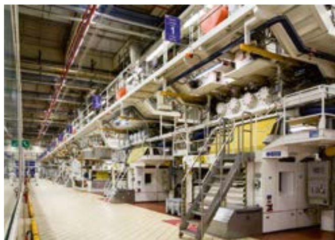
Interno dello stabilimento Barilla di Pedrignano a Parma
