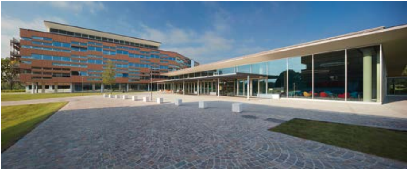
Centro Direzionale Crédit Agricole Green Life, la sede ecosostenibile del Gruppo Bancario, alle porte di Parma: 12mila metri quadrati edificati, immersi in settantamila metri quadrati di parco, con openspace multifunzionali
