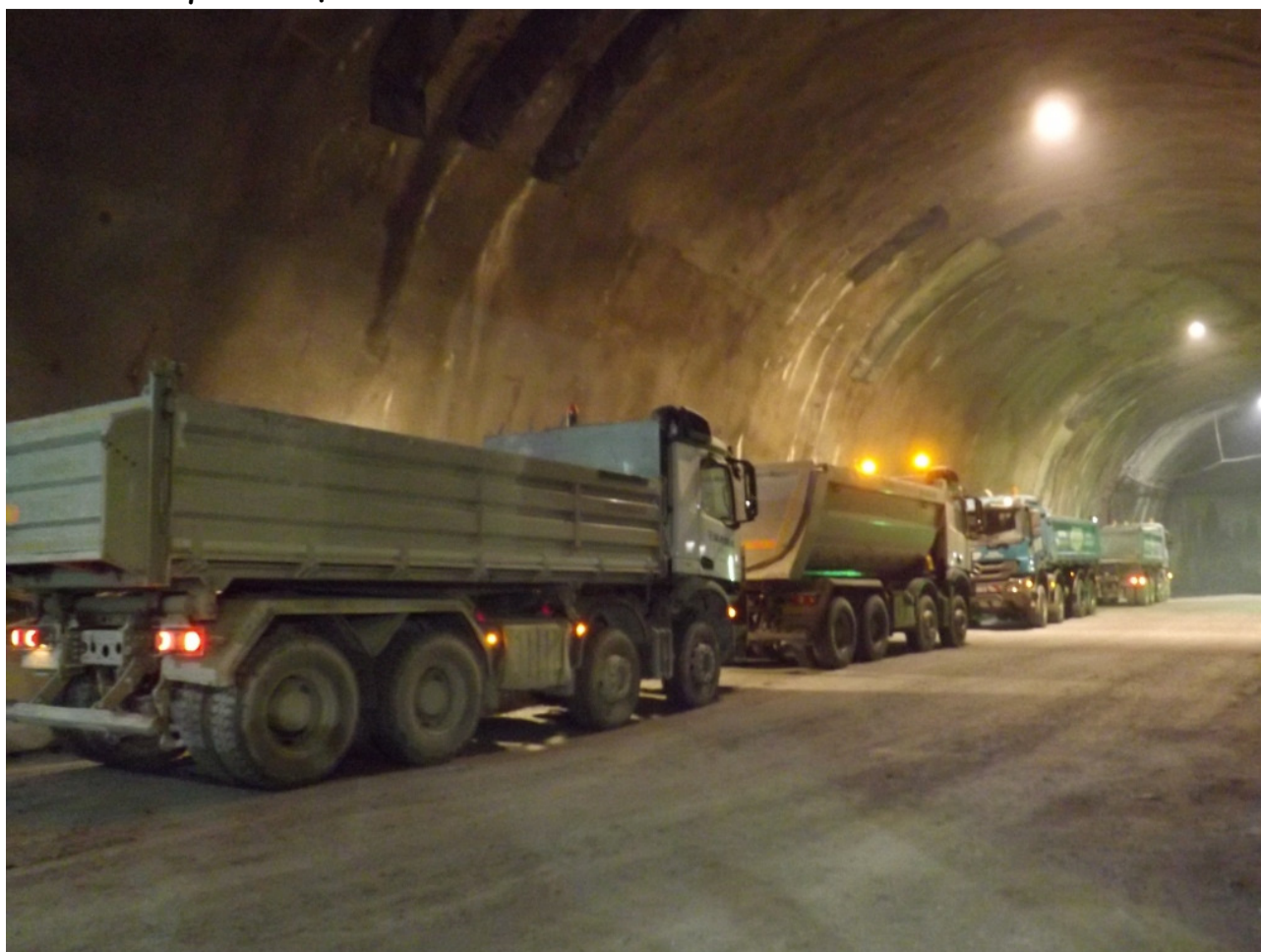
lavoro nel tunnel - Arbeit im Tunnel
