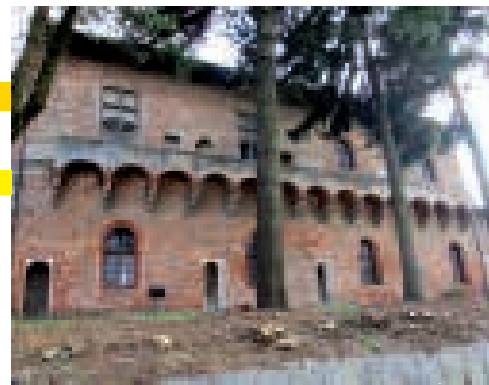
Facciata nord del castello di Mirabello
